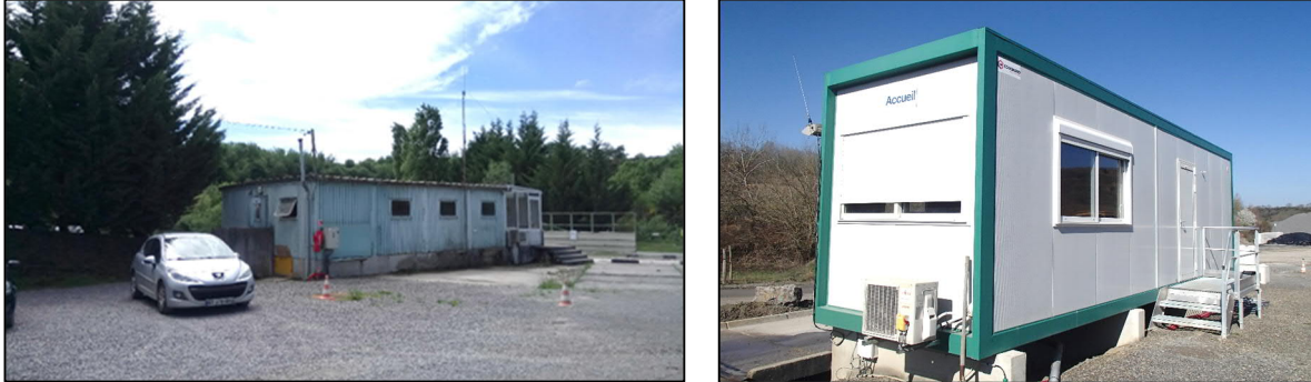
Figure 34 - Locaux sociaux, parking visiteurs et bureaux d'accueil
