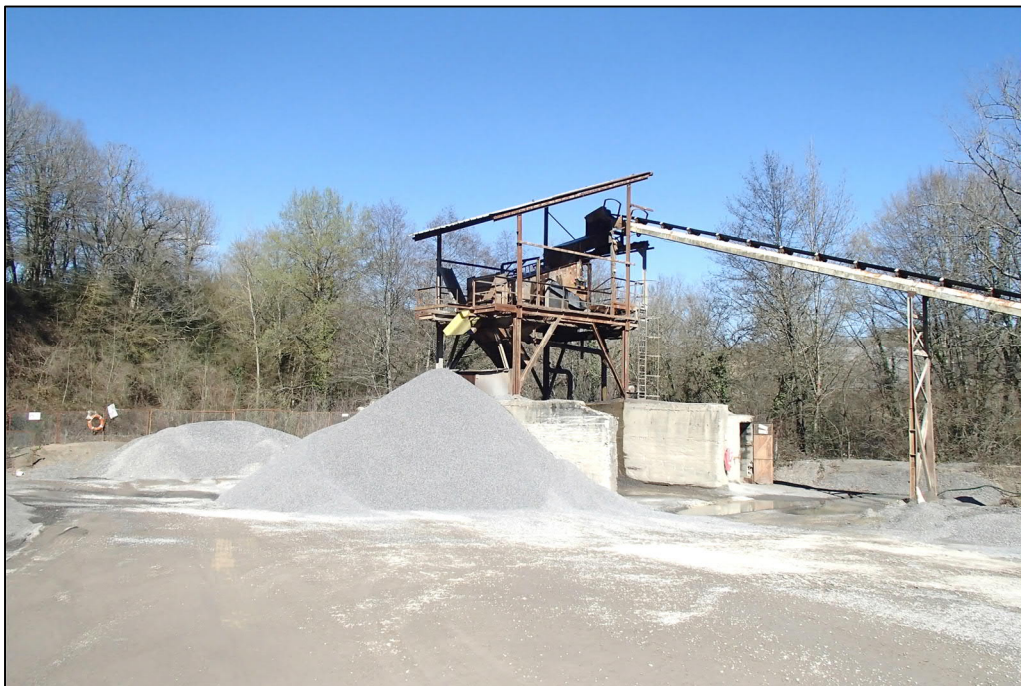
Figure 27 - Bâtiment de criblage / lavage des matériaux et stock de gravillons lavés
