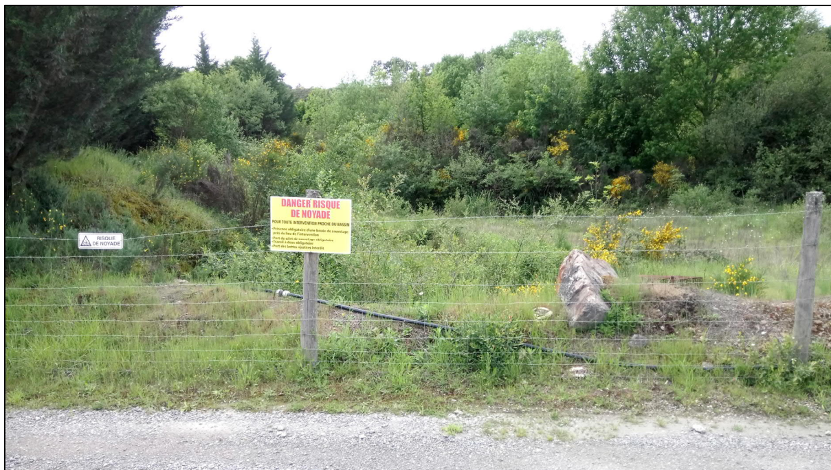
Figure 19 - Les bassins de décantation des eaux d'exhaure
