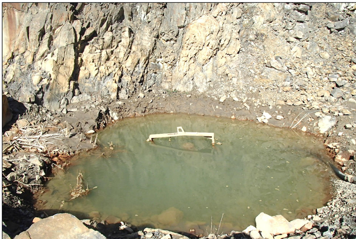
Figure 17 - Bassin de pompage en fond d'excavation dans la fosse de Bonneuil
