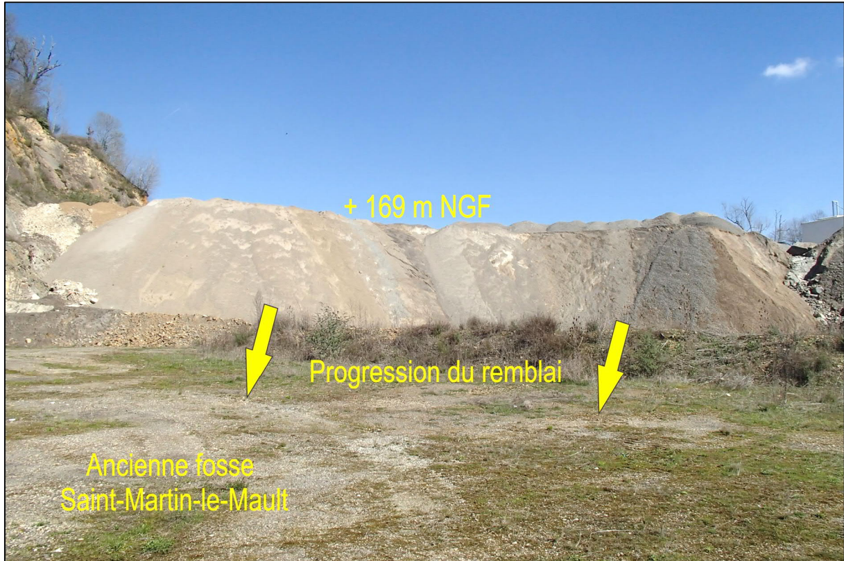
Figure 20 - Remblayage en cours à la cote + 169 m NGF
