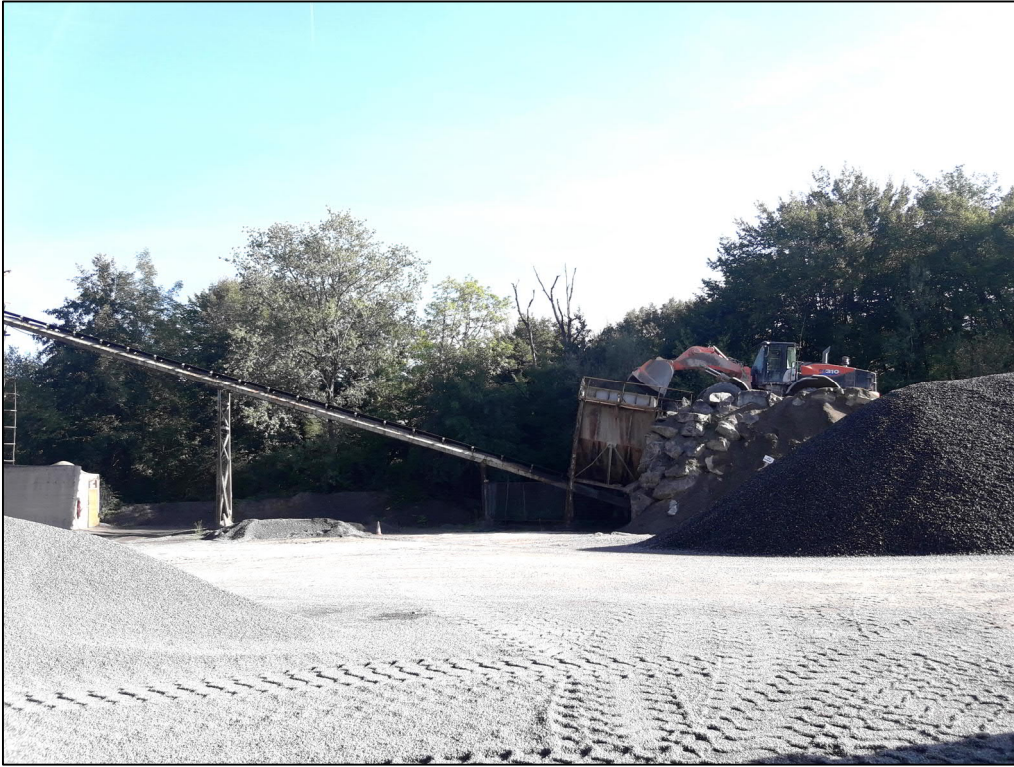
Figure 26 - Chargeuse alimentant la trémie de l'installation de lavage
